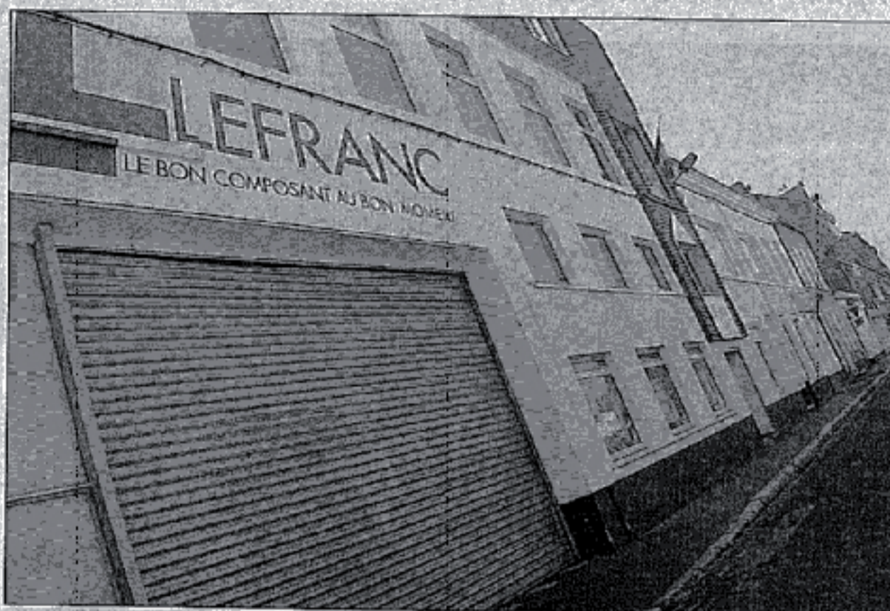
La maison Lefranc sera presque au cœur du chantier.
